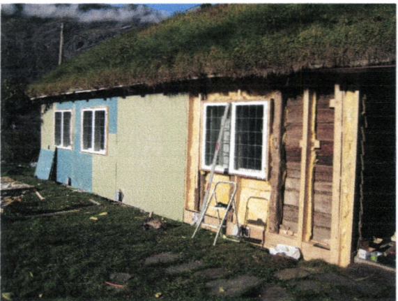
Vegg mot sør, Rettet og erstattet råte. Isolert/platet
