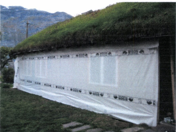
Vegg mot sør, ferdig for kledning
