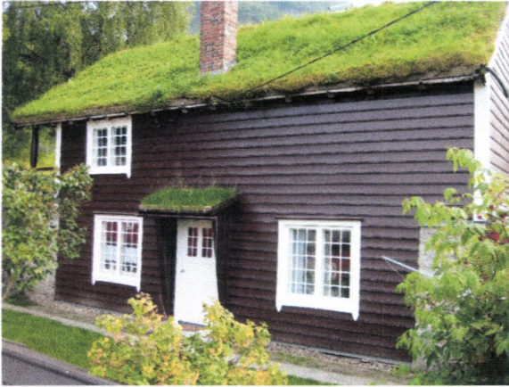
Vegg mot nord, ferdig restaurert
