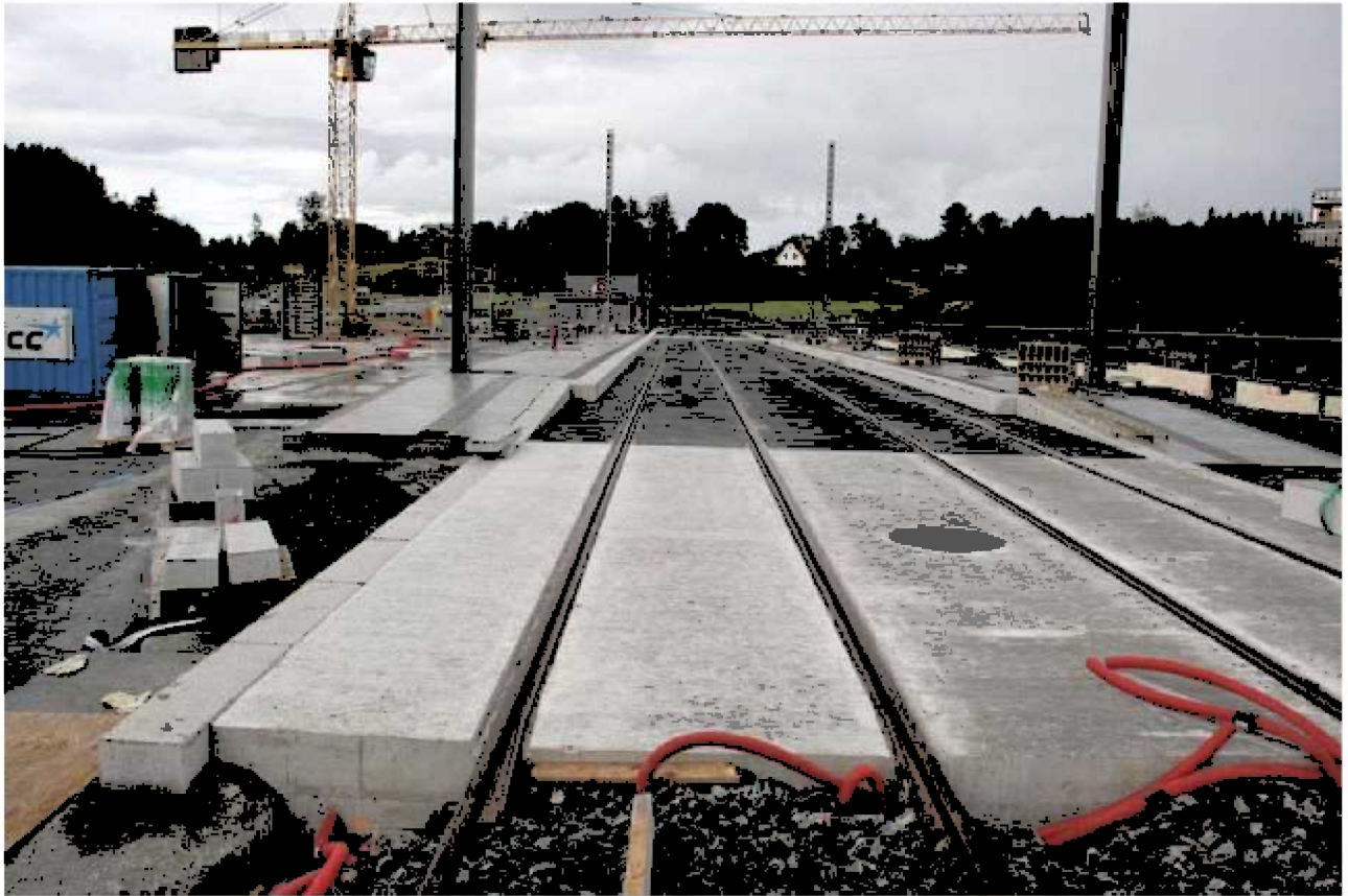
Bybanens byggetrinn III, Birkelandsskiftet terminal. Foto: Rune Jensen
