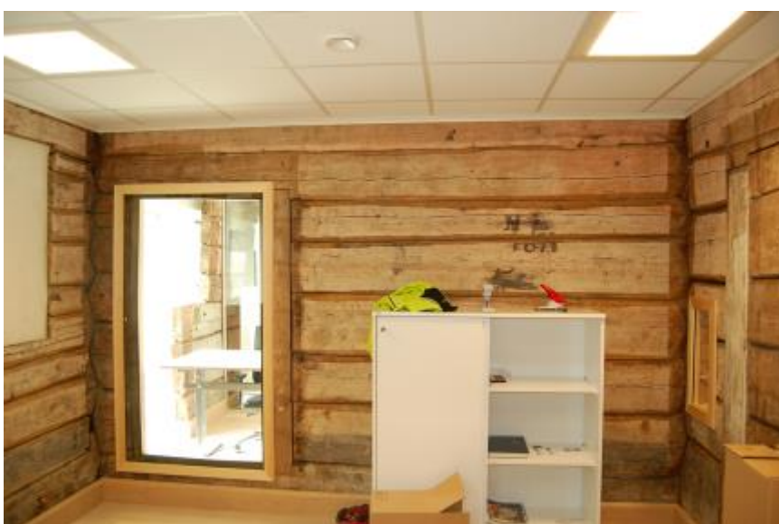
Nordastre rom, vegg E
