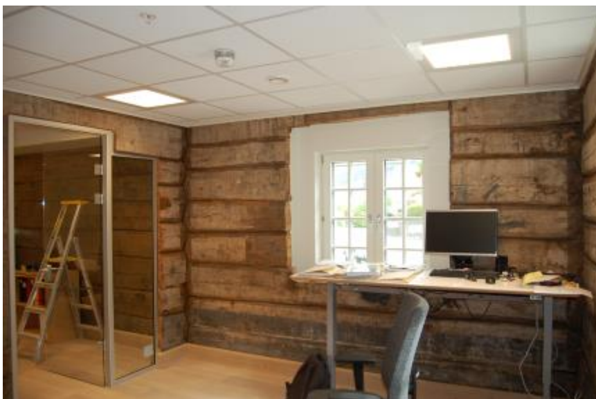
Nordastre rom, vegg H
