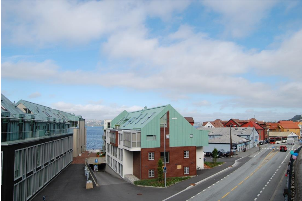
Sandviksbodene 3 A sett frå aust. Til v. Sandviken sjøfront, til h. i bakgrunnen det samanhengande sjøbodmiljøet Sandviksbodene 8-23
