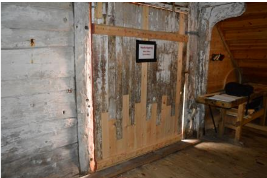
1. etasje, port i austveggen
