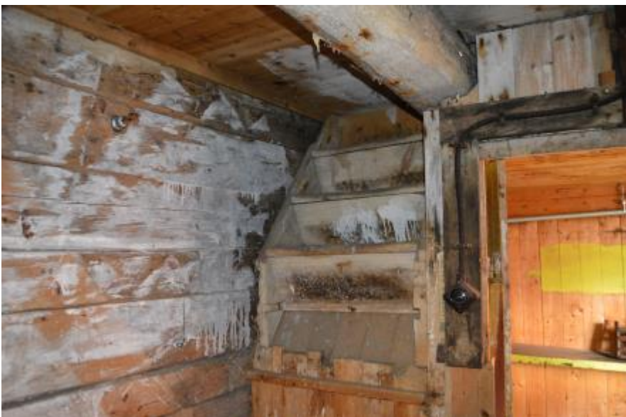
3. etasje, rest av loftstrapp i svalgangen langs austveggen
