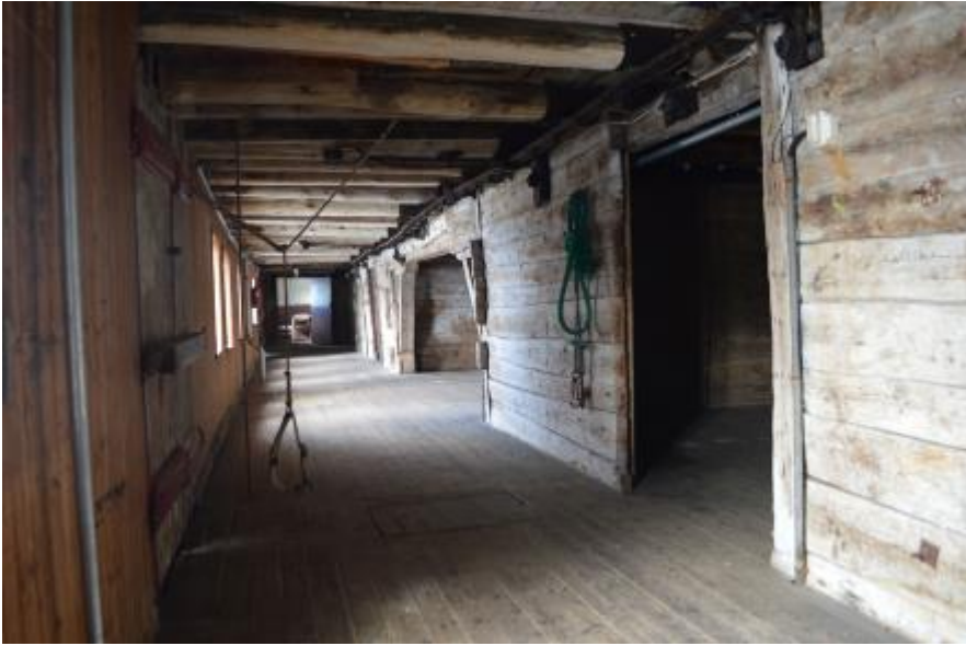
3. etasje, svalgangen langs sørveggen sett mot vest
