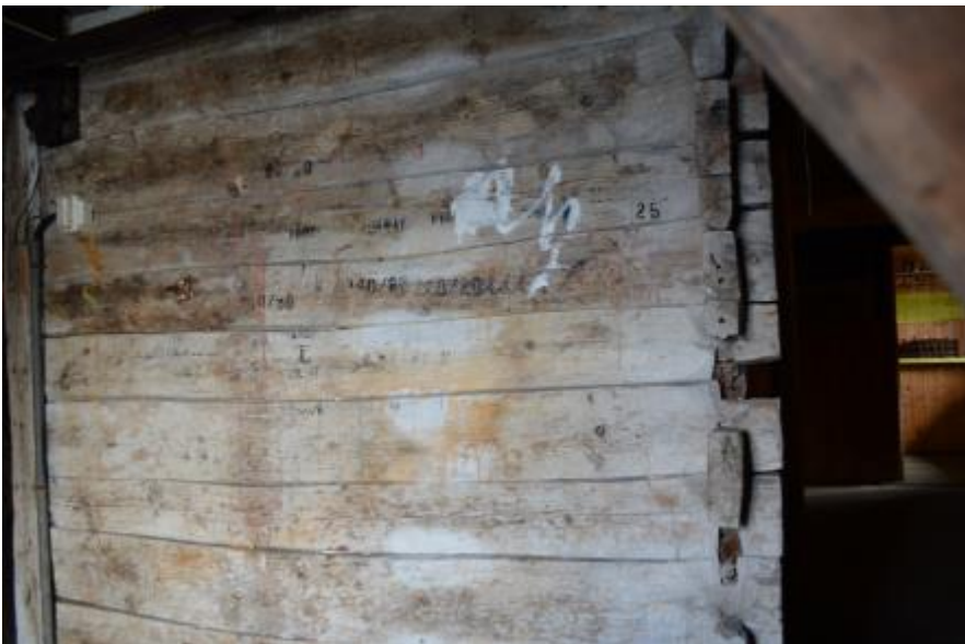
3. etasje, hjørnet mellom svalgangane langs sør- og austveggen, sett mot nord
