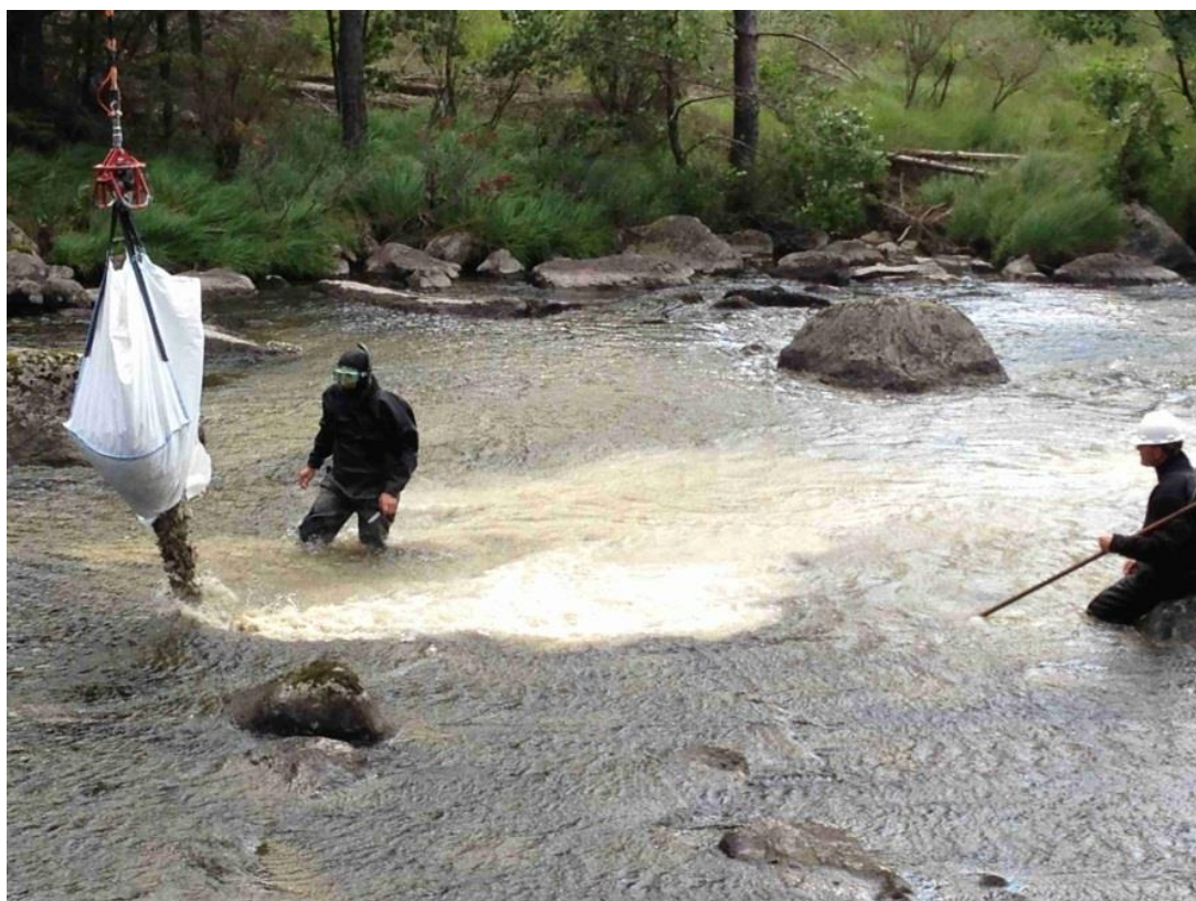
Figur 17: Avbøtende tiltak, ved utlegging av gytegyrus i Jørpelandselva. Foto: Lyse produksjon AS
