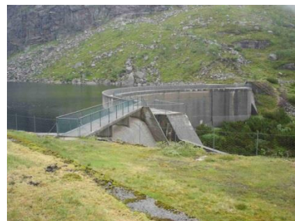
Figur 16: Vannkraftverk er en av de hyppigst registrerte påvirkningene på elv og innsjø i vannregionen. Her illustrert ved dam ved Store Myravatn. Foto: Vegard Næss, Rogaland fylkeskommune.
