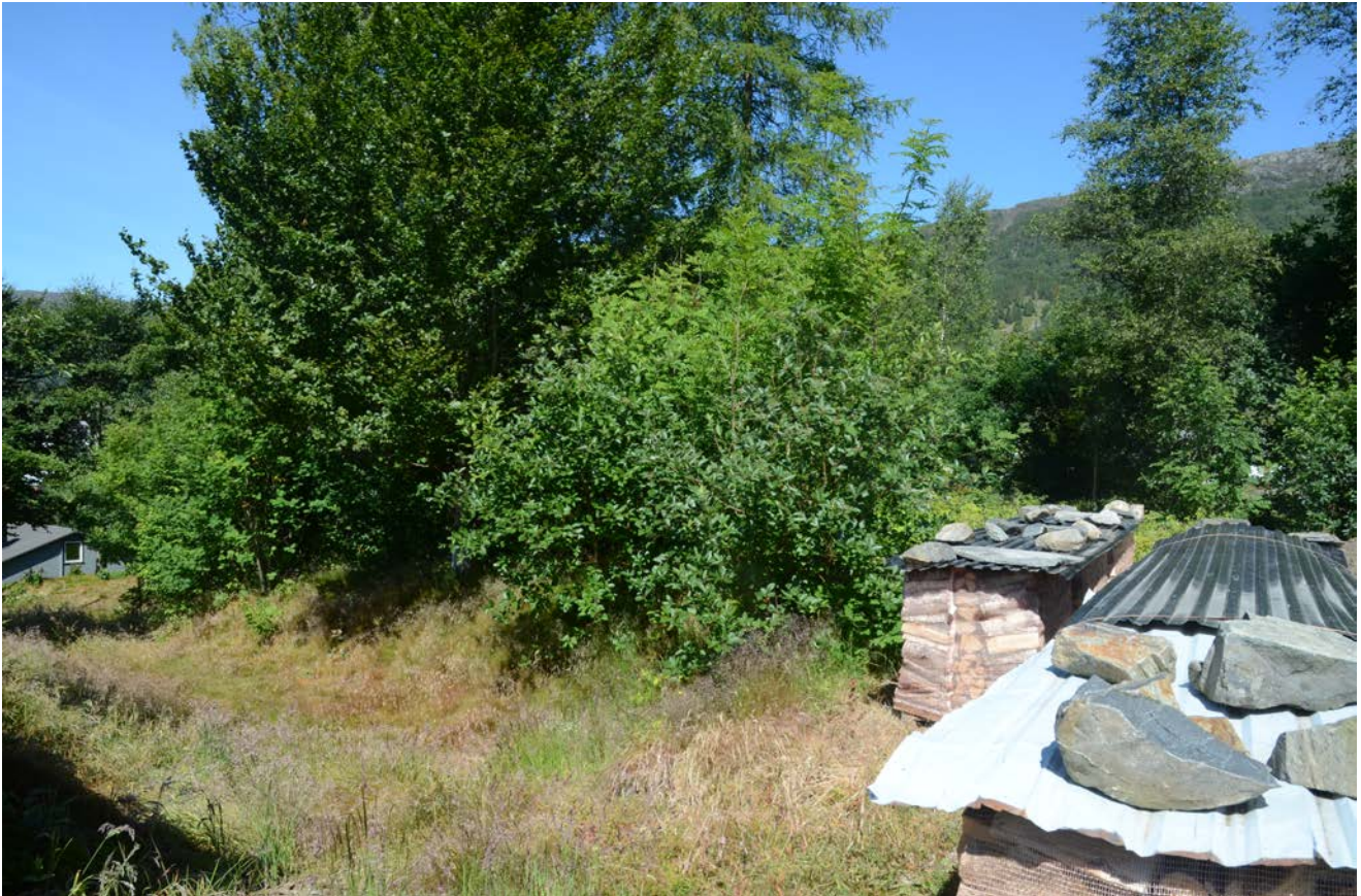
figur 2 Olahaugen før opprydding og sikring av skade på kulturminnet i 2014
