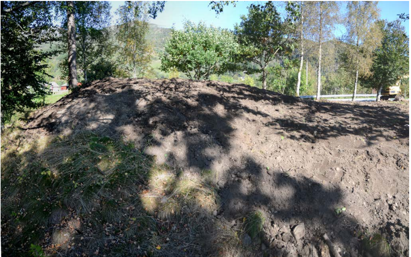
figur 10 Haugen sett mot aust etter at massane er lagt på plass.
