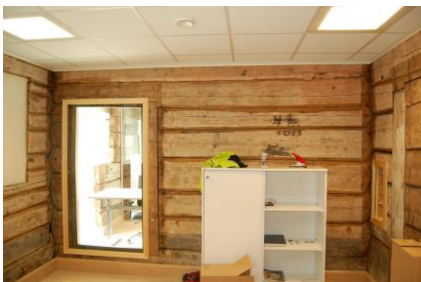
Nordaustre rom, vegg E
