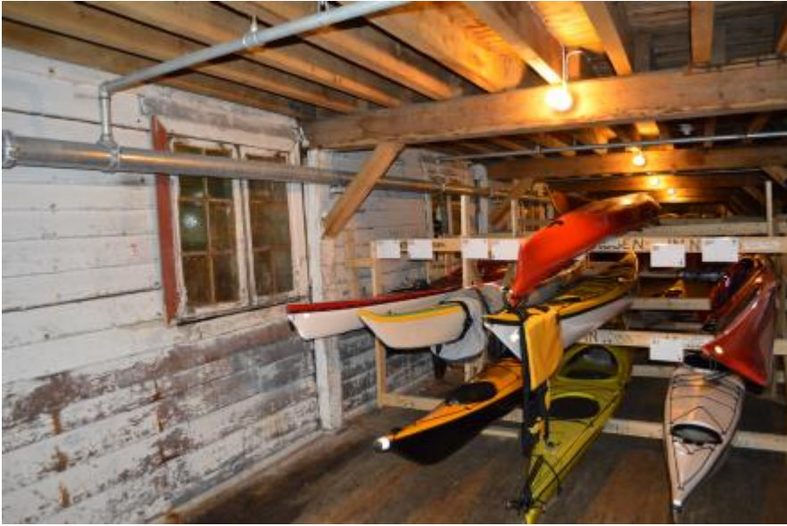
1. etasje i tilbygget på nordsida, sett mot vest. Til v. ytterveggen i den opphavlge boden
