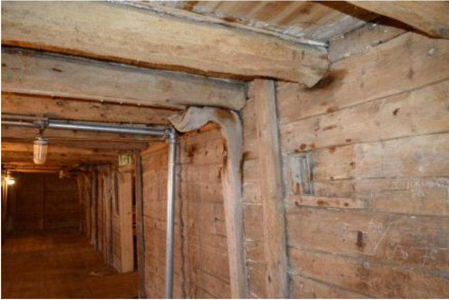
2. etasje, hovudrommet i sjøve boden sett mot vest. Nordveggen (opphavleg ein yttervegg)
