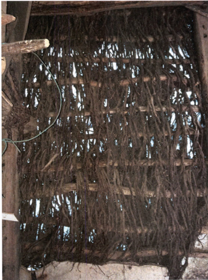
Den gamle kledningen sett frå innsida.
