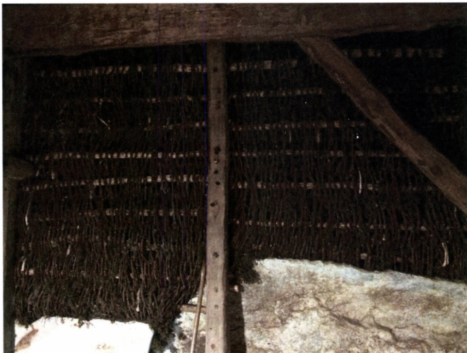
Det same partiet til venstre i bildet. Ny kledning.
