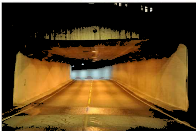
Figur 19. Tverrprofilen i Sydnestunnelen varierer.
