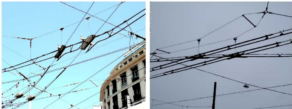
Figur 5 – Eksempler på kryssing av kjøreledning til trikk (foto: Bybanen)
