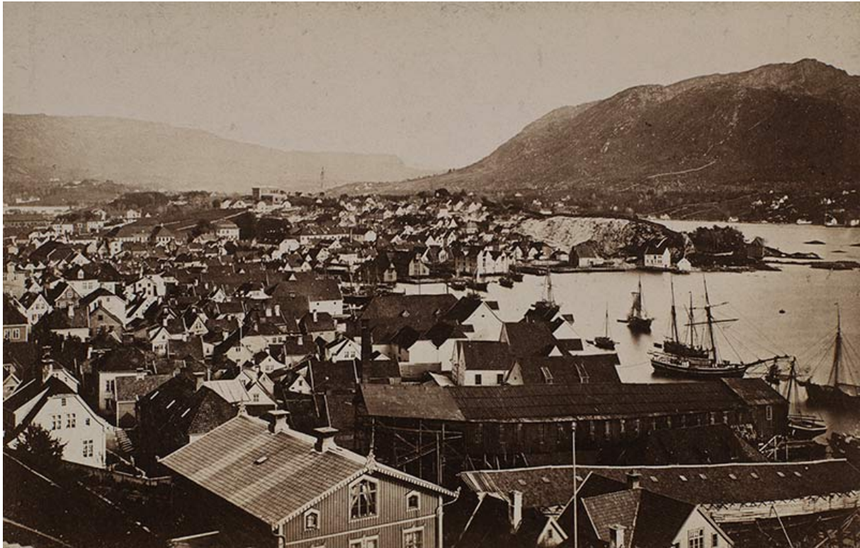
Figur 10. Dette bildet er tatt før pipen ved Dokkhuset ble bygget, en gang mellom 1862 og 1869. Fremst i bildet ligger «Villa Bakken», i Galgebakken 2, oppført i 1856 av Johan Mungaard Dekke som var far til Annanias Dekke. Bygget er borte i kart fra 1957. Fotograf: Marcus Selmer. Billedsamlingen UiB.
