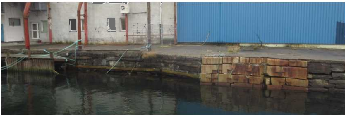
Figur 20. østlig side av tørrdokken. Området der dokkskipet kunne stenge av er bygget med annen type stein.
