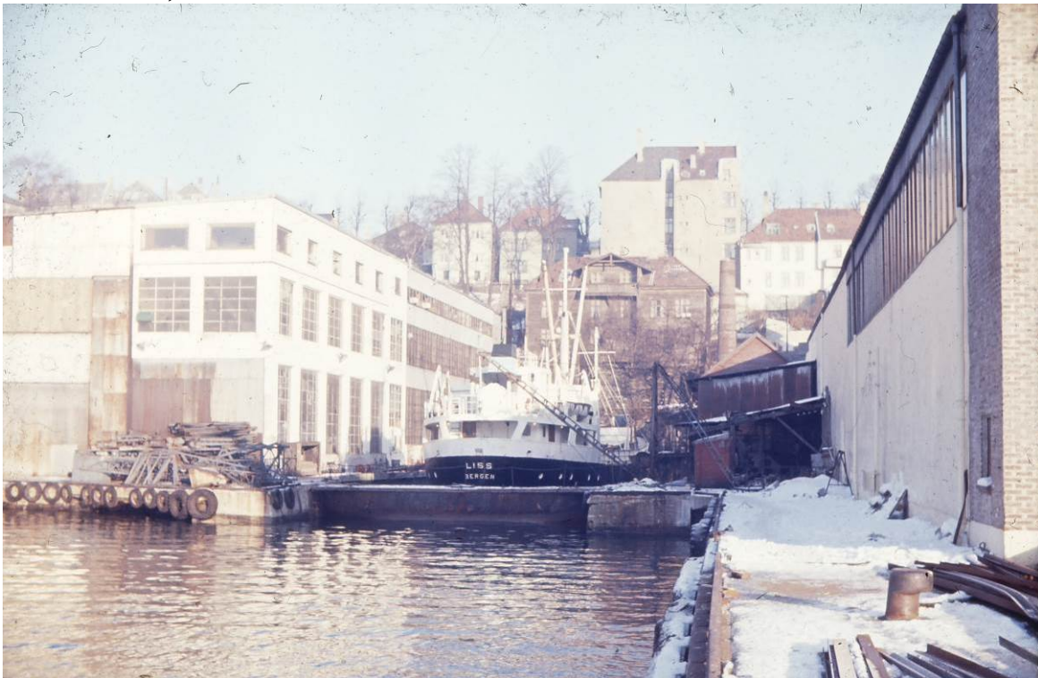
Dokken og verftsbygg fra 1970-tallet
