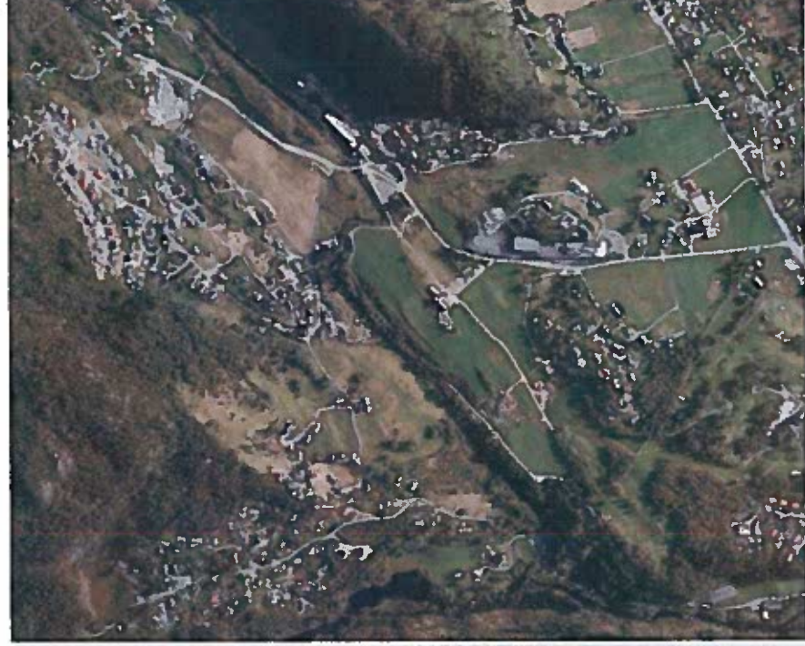
2. Hatvikvegen – Valla bru (langs Hegglandsdalsvegen), Ca. 910 meter lengde
