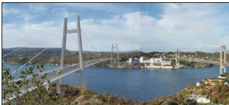
Figur 2. Fotomontasje/illustrasjon av den nye Sotrabrua sør før eksisterende bru.
