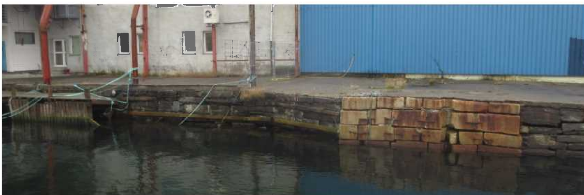
Figur 20. østlig side av tørrdokken. Området der dokkskipet kunne stenge av er bygget med annen type stein.
