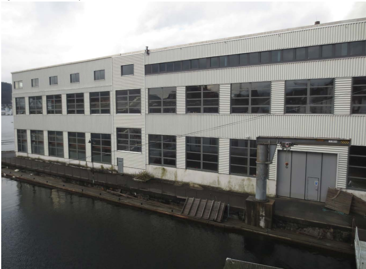
Figur 25. Fasade mot tørrdokken
