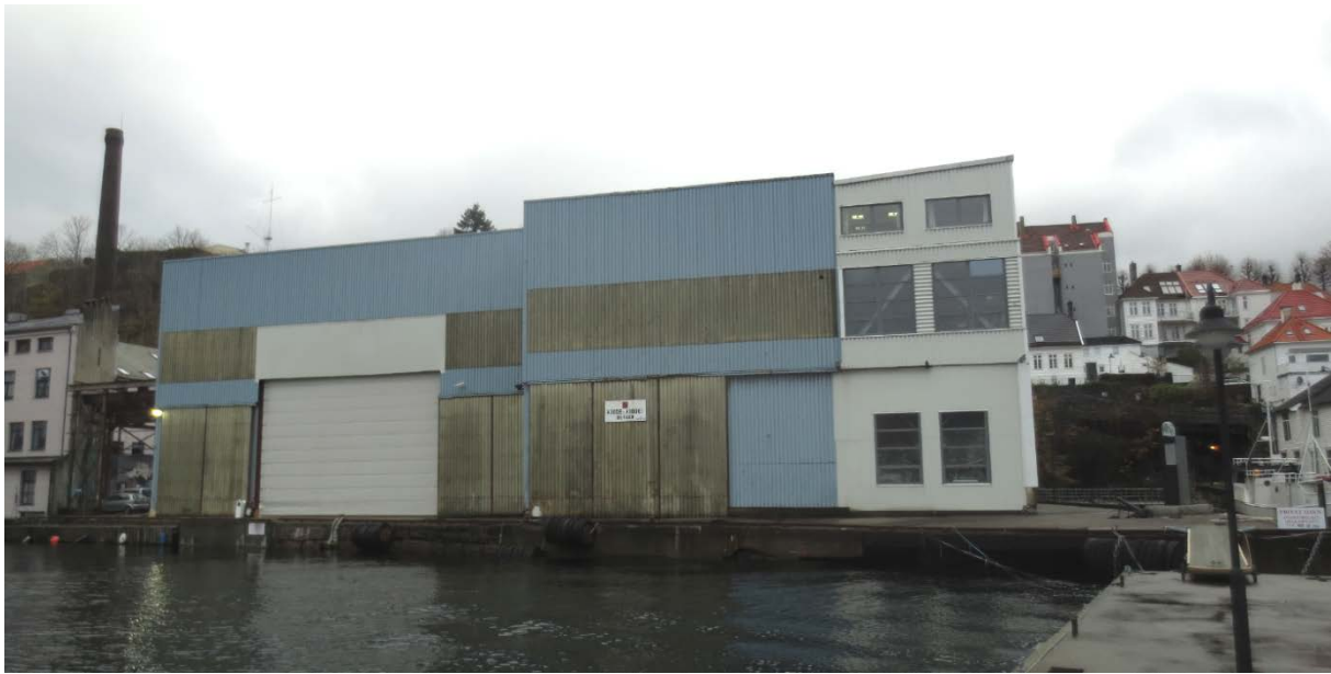
Figur 24. Fasaden mot sjø.
