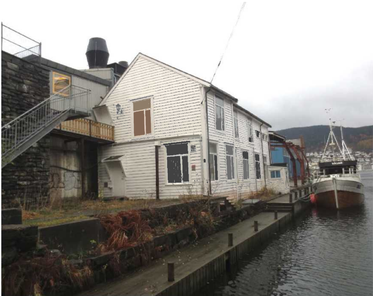
Figur 19. Nordlig del av Dokkhuset er borte, men er synlig i fundamenter og trapp nærmest fotografen.
