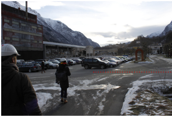
Parkering på byggetomten ved Ovn III
