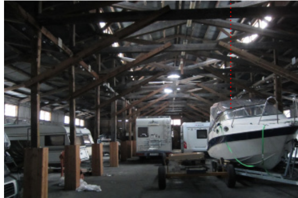
DICY, bygning 37/206, anvendes i dag til lager og oplag af både, campingvogne og køretøjer.
