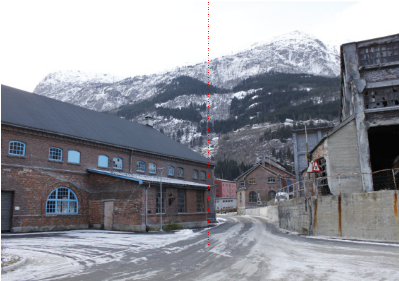
Smal urban bilpassage mellem Smelteverkets to plateauer, Cyanamiden og Ovn III/ Skalltaket - her fremstår bygningsmassen meget autentisk og kompakt
