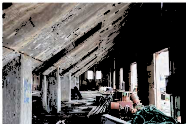
Kikk gjennom bygg 05. Skånsomt istandsatt kan bygningen danne ramme om servicefasiliteter til fjordbad og gjestehavn samt inngå i hotell/ minihotell funksjoner.
