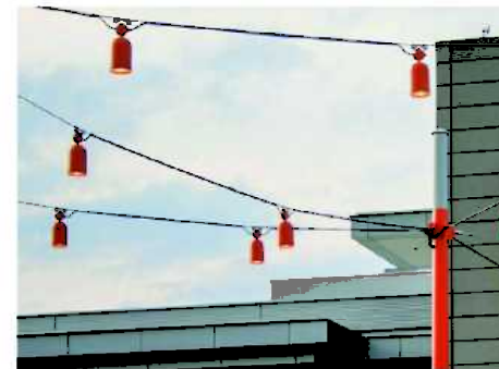
Referansebilde: Armaturer i wirestrekk
