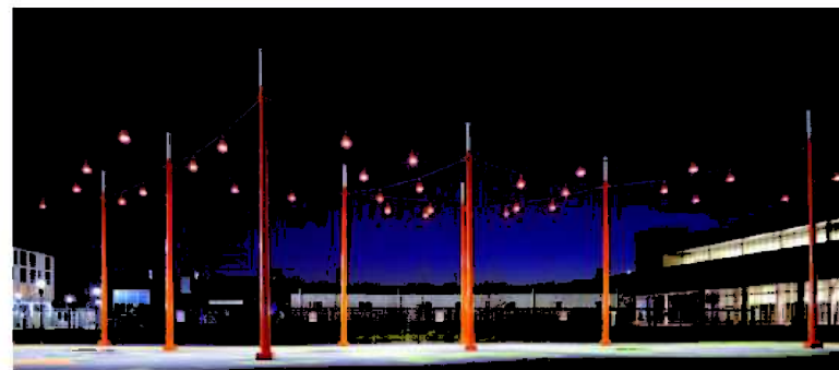
Referansebilde: Armaturer i wirestrekk
