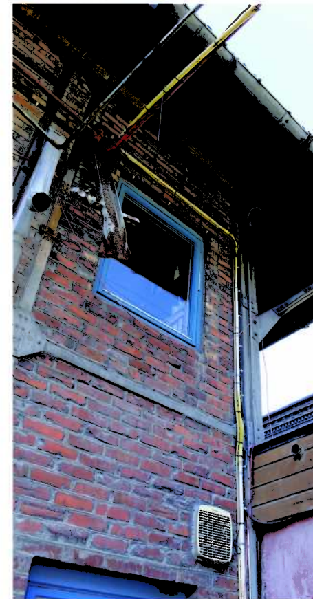
Detalj på taket hvor aramaturer skal monteres
