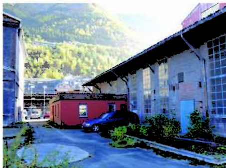
Smug med brakkebygg som skal fjernes
