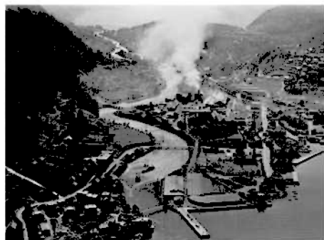
Flyfoto: Odda smelteverk i drift
