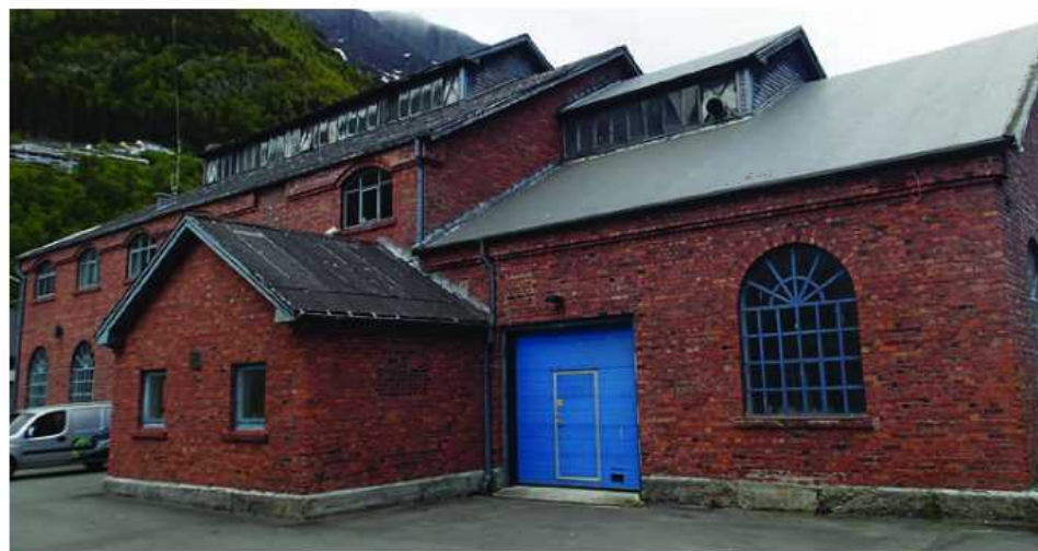
Mursteinsbygg i nærheten av Lindetorget
