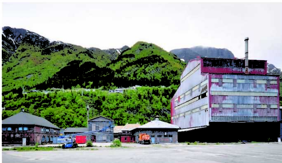
Ovn 3 og lave mursteinsbygg
