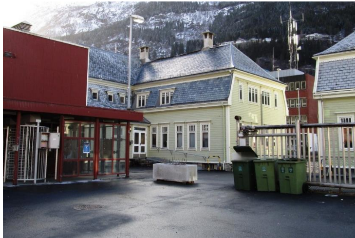
Inngangen til området med administrasjonsbygningene (verneverdige) og portvakthuset (ikke vernet): ett flat tak og to valmede.
