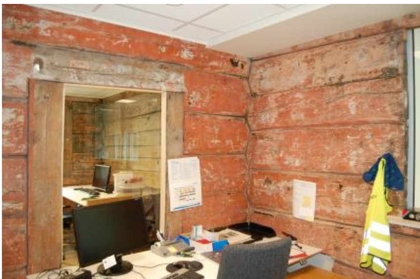
Sørvestre rom, vegg B (til venstre) og vegg A
