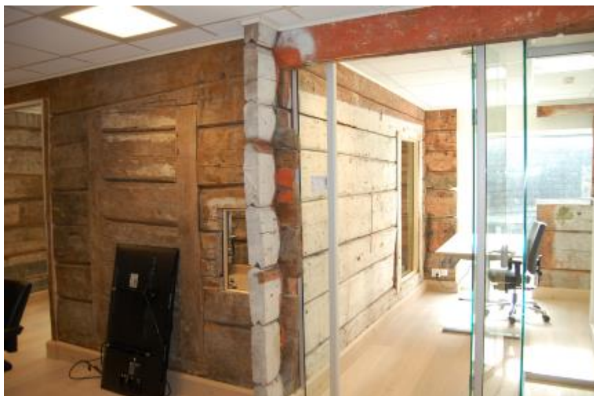
Vegg I (til venstre) og vegg E
