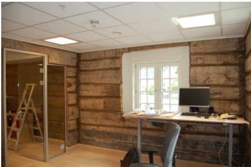
Nordastre rom, vegg H
