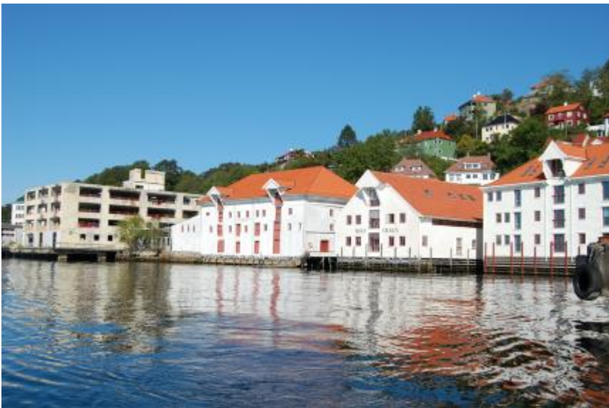
Miljøet sett frå søraust. Lengst til v. betongskjelettet til Sandviksbodene 78 C, eit lagerbygg frå 1950-åra
