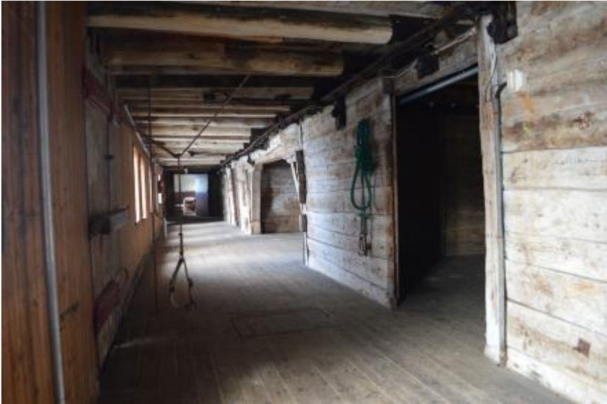
3. etasje, svalgangen langs sørveggen sett mot vest
