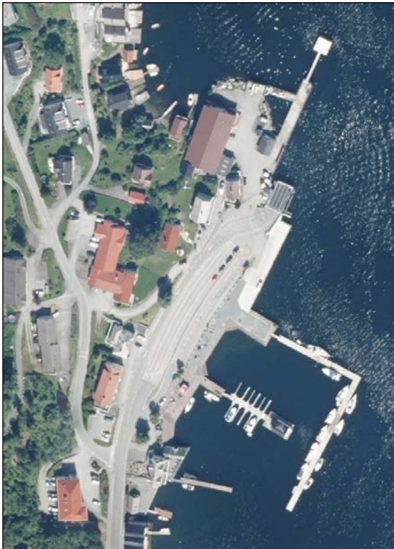
Eksisterande ferjekai og småbåthamn i nord.
