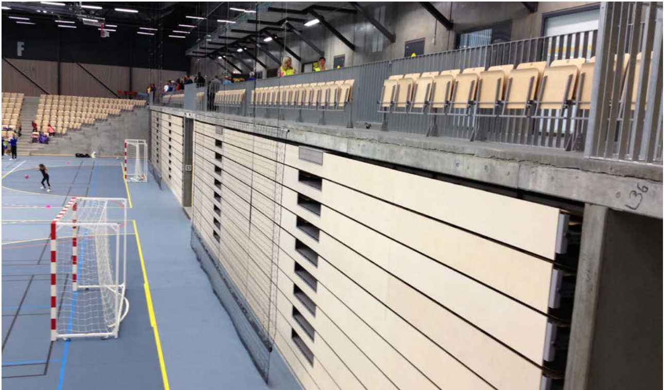
Teleskoptribune, her parkert i «garasje». (NB: nærmeste håndballmål er ikke sikret mot velting). Foto: Morten Roa
