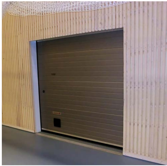
Port til lagerrom. Foto: Morten Roa
