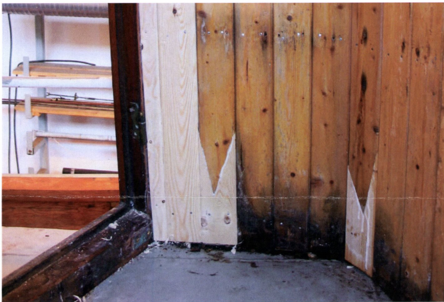
Et forsøk på å bevare mest mulig av de opprinnelige panelene i styrhuset på «RS Bishop Hvoslef». Råteskadde deler er byttet ut med frisk materiale av tilsvarende kvalitet. NNFA.
