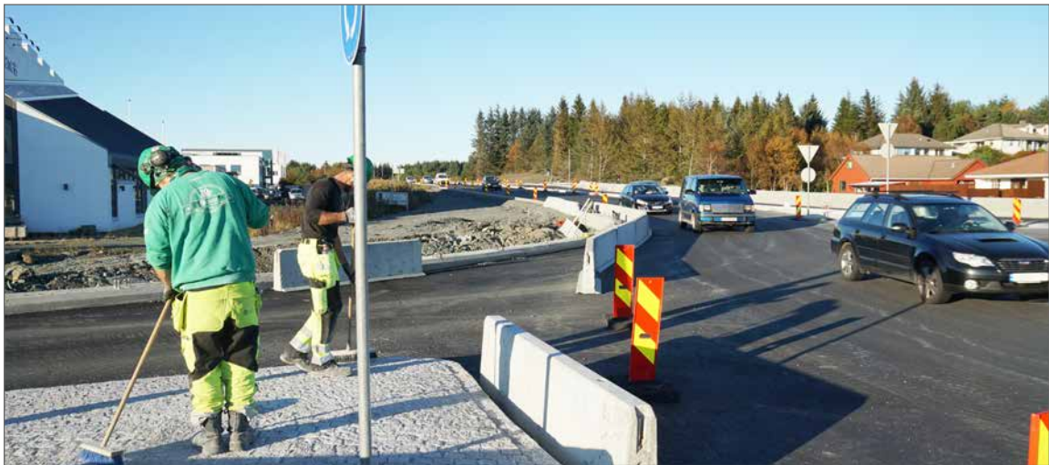
Utbedring av Fylkesvei 47 på Karmøy
