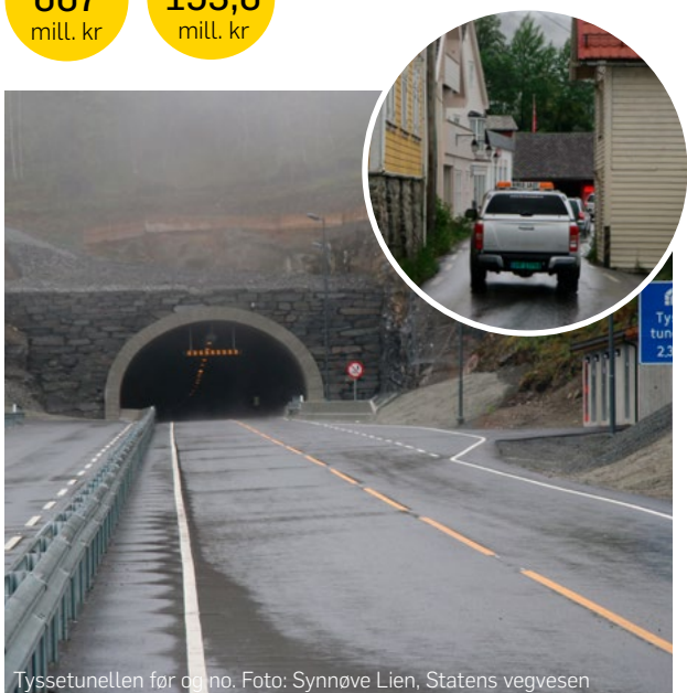
Tyssetunellen før opno. Foto: Synnøve Lien, Statens vegvesen
