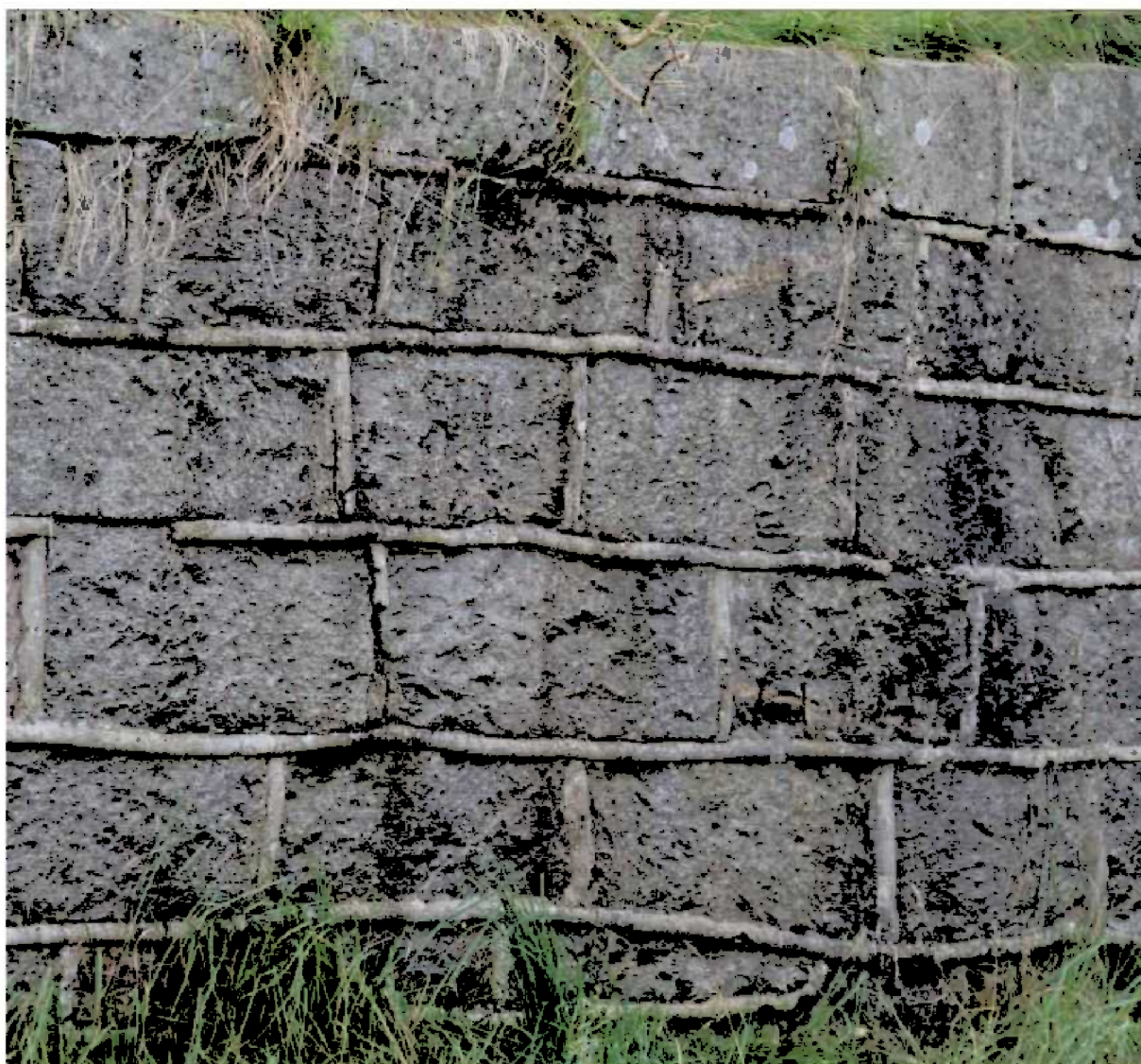
Muren har karakteristiske sementfuger. Bilde: Byantikvaren.
