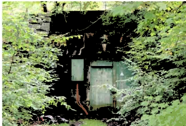
Inngang til bunkertunnel i sør. Bilde: Byantikvaren.
