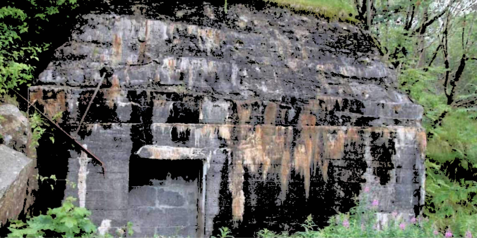
Inngang til bunkertunnel i nord. Bilde: Byantikvaren.
