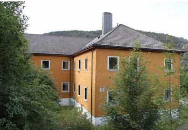
Bygget er formet som en speilvendt "L". Bilde: Byantikvaren.
