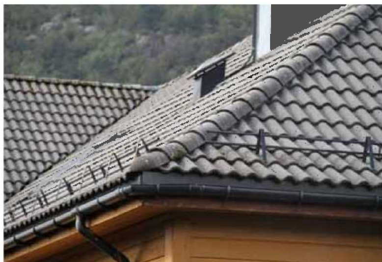
Taket var opprinnelig tekket med skiferstein. I dag er det betongstein på taket. Bilde: Byantikvaren.
