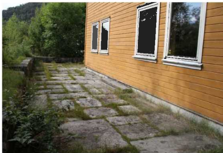
Bildet viser plattingen i sør. Vi ser trappetrinnet som viser hvor døren en gang har stått. Bilde: Byantikvaren.
