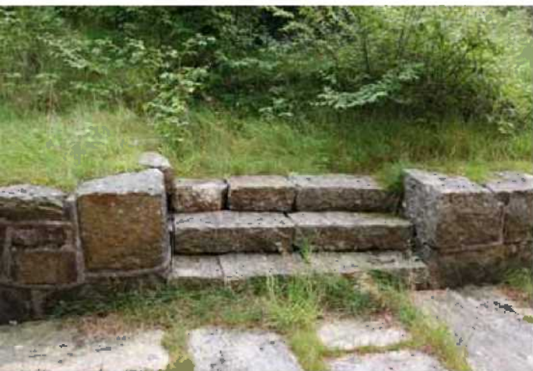
Trapp fra platting til sti. Vi ser også de karakteristiske murfugene her. Bilde: Byantikvaren.
