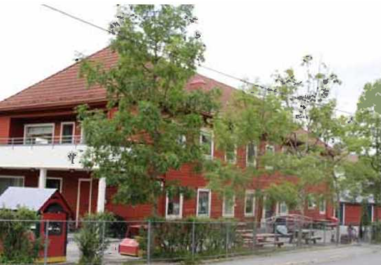
Det er i dag barnehage i den tidligere mannskapsbrakken i Sverre Hjetlands vei 17. Bilde: Byantikvaren.
