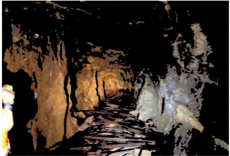
Inne i bunkertunnelen ved Willy Valentinsens vei 34. Bilde: Byantikvaren.
