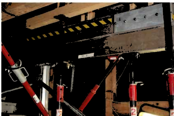
Montering jekkerigg (1) (IMG_9112)
