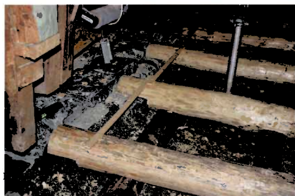
Arbeider bolverk, rom 102 (2) (IMG_9043)
