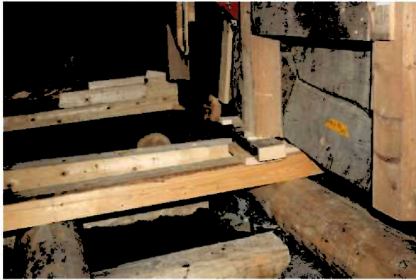
Oppheng av laft, rom 102 (IMG_9083)
