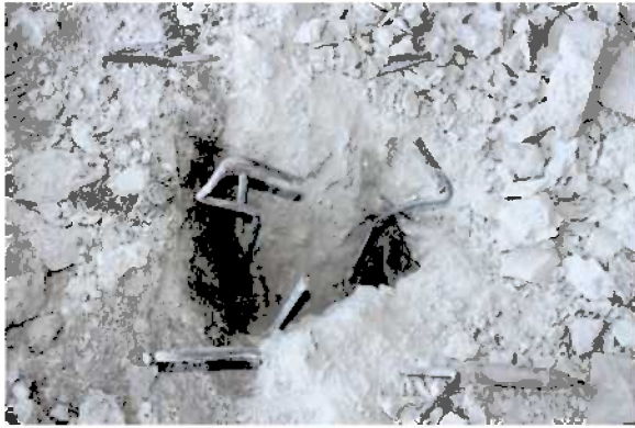
Fjerning av armert betong, 101 (1) (IMG_9138)
