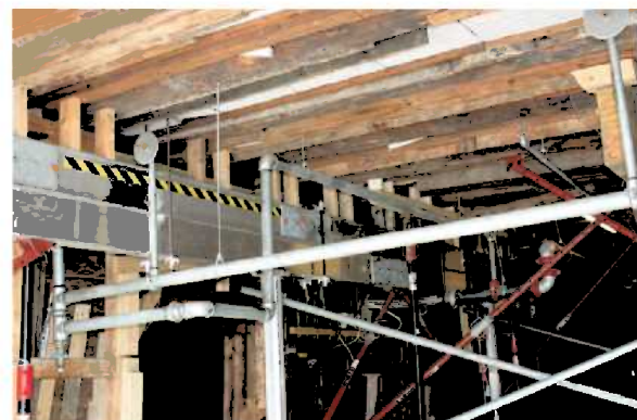
Montering jekkerigg (2) (IMG_9119)
