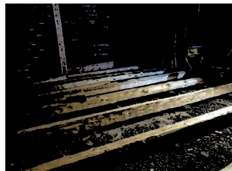
Montering av bjelker (IMG_1595)
