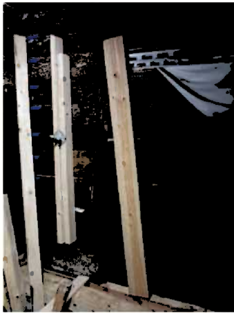
Montering av beitski (IMG_1596)
