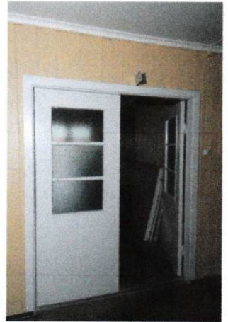
Tofløyet dør korridor mot bislag. Foto: Leif Anker, Forsvarsbygg
