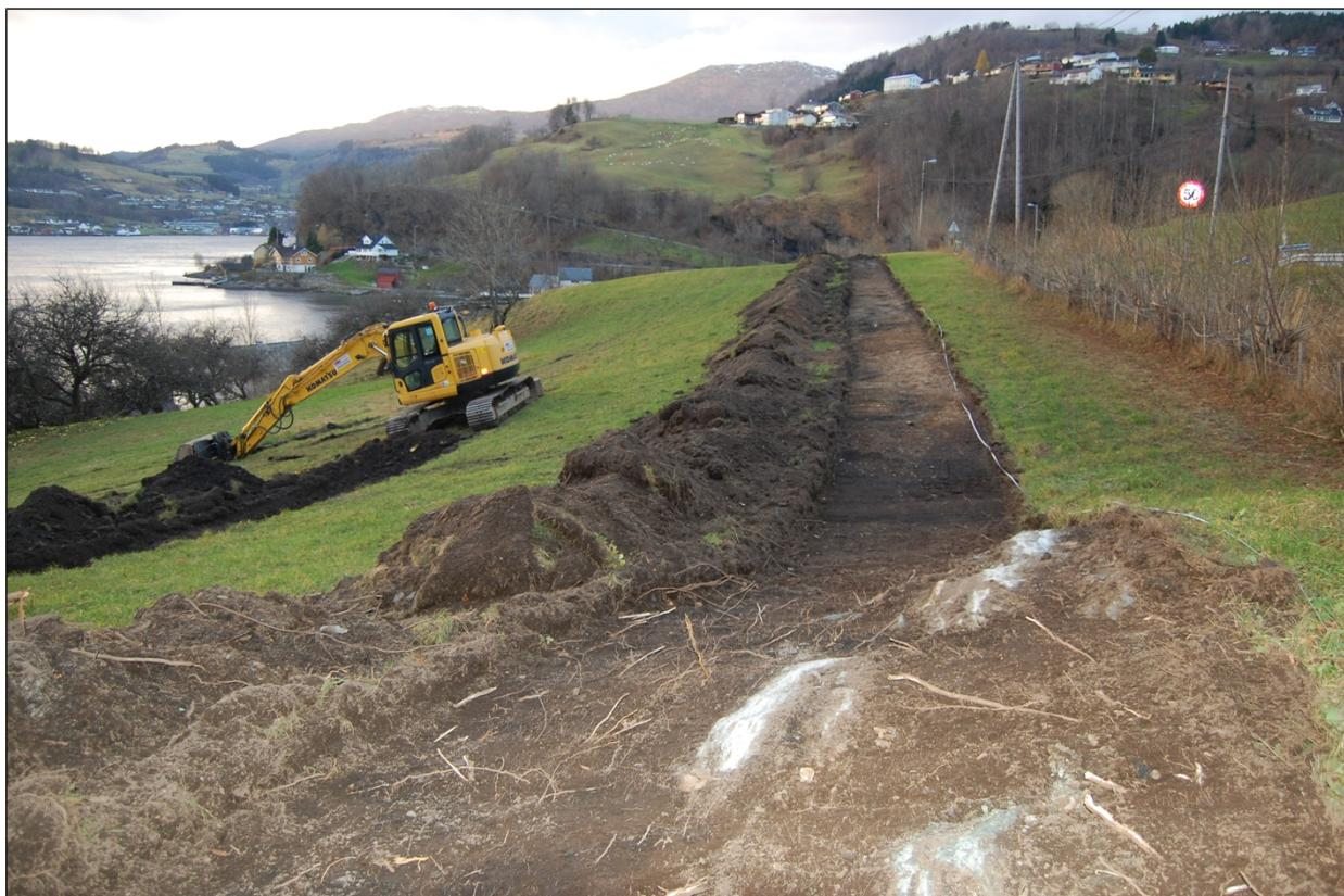
Illustrasjonsfoto av maskinell sjaktning. Merk at søkesjaktene kan vere langt djupare om det er naudsynt å fjerne rasmasse eller påfylt masse.
