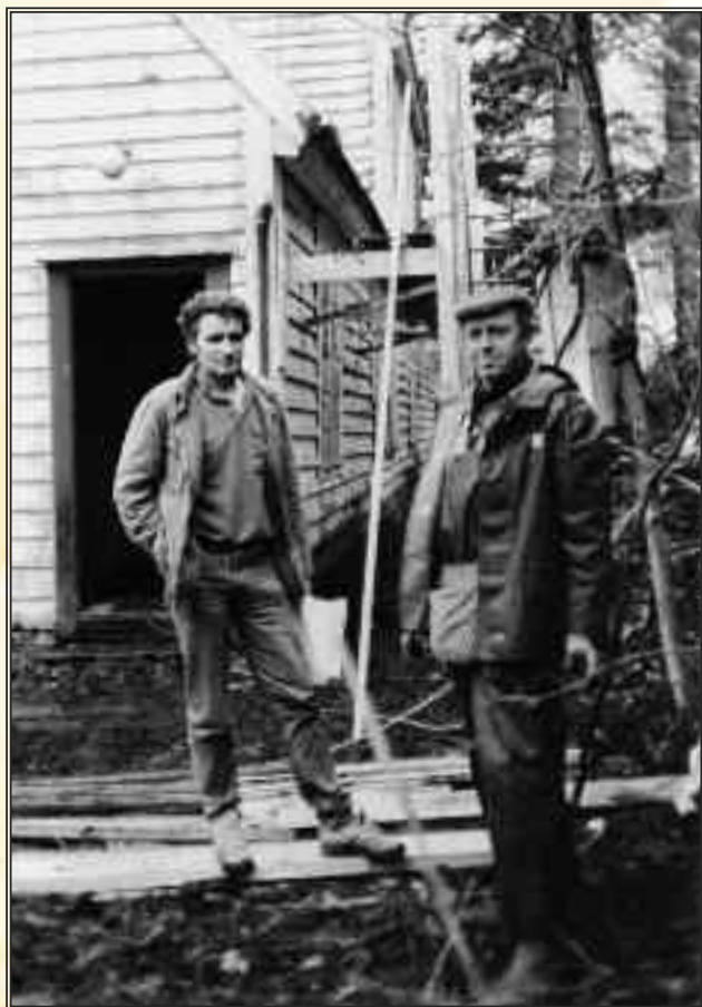
Kjell Tofte og Svein Hopland fra Halsnøy Trelast var ansvarlige for omlegging av taket på Hovedhuset i oktober 1986 (foto: T. Grung)
