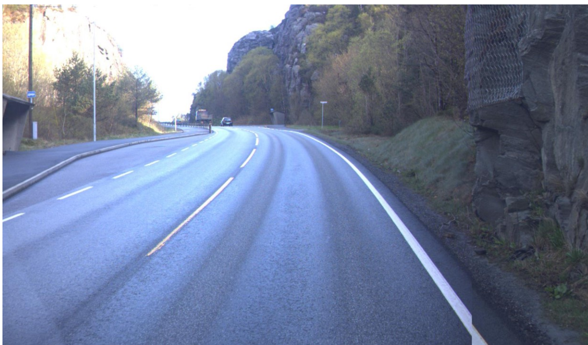
(Fv. 561, hp 1, km 6,462) til høyre i bildet
