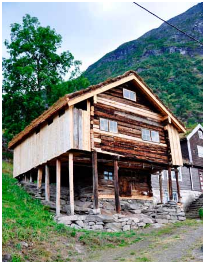
Stabburet i Møllstunet vart ferdig restaurert i 2015.
