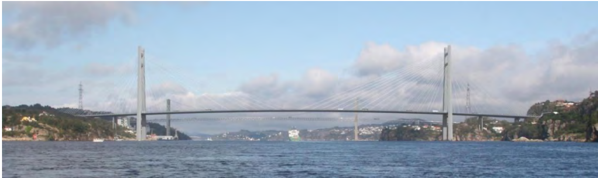
Figur 8.12 Illustrasjon av skråstagsbru med H-tårn (frå sør)
