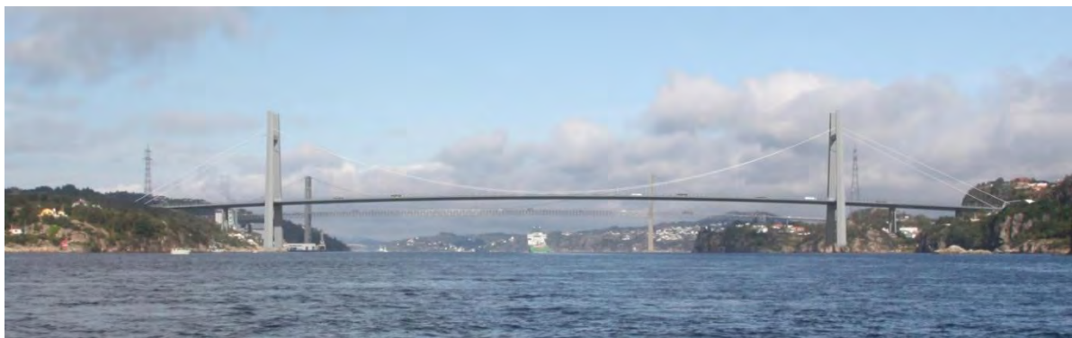
Figur 8.10 Illustrasjon av hengebru med H-tårn (frå sør)
