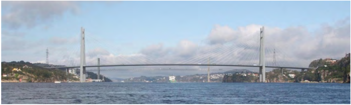
Figur 8.12 Illustrasjon av skrånstagsbrua med H-tårn (frå sør)
