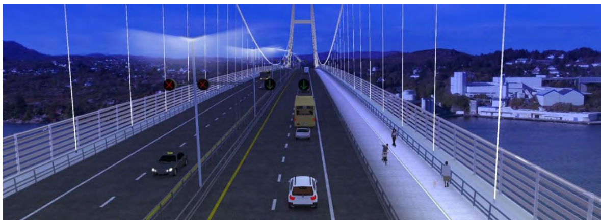
Figur 9.44 Belysning av køyrebane og gangfelt.
