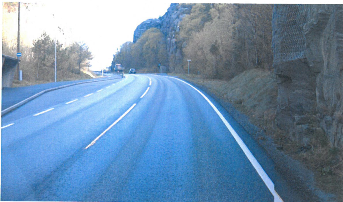
(Fv. 561, hp 1, km 6,462) til høyre i bildet
