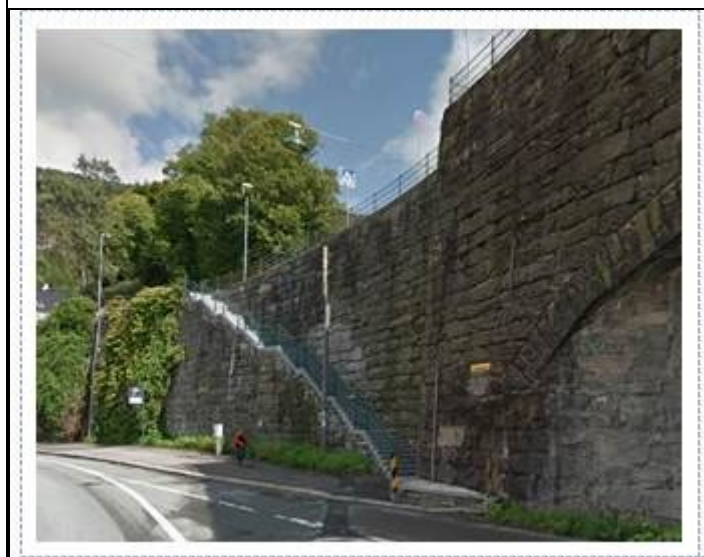
Mur mot Sjøgaten
