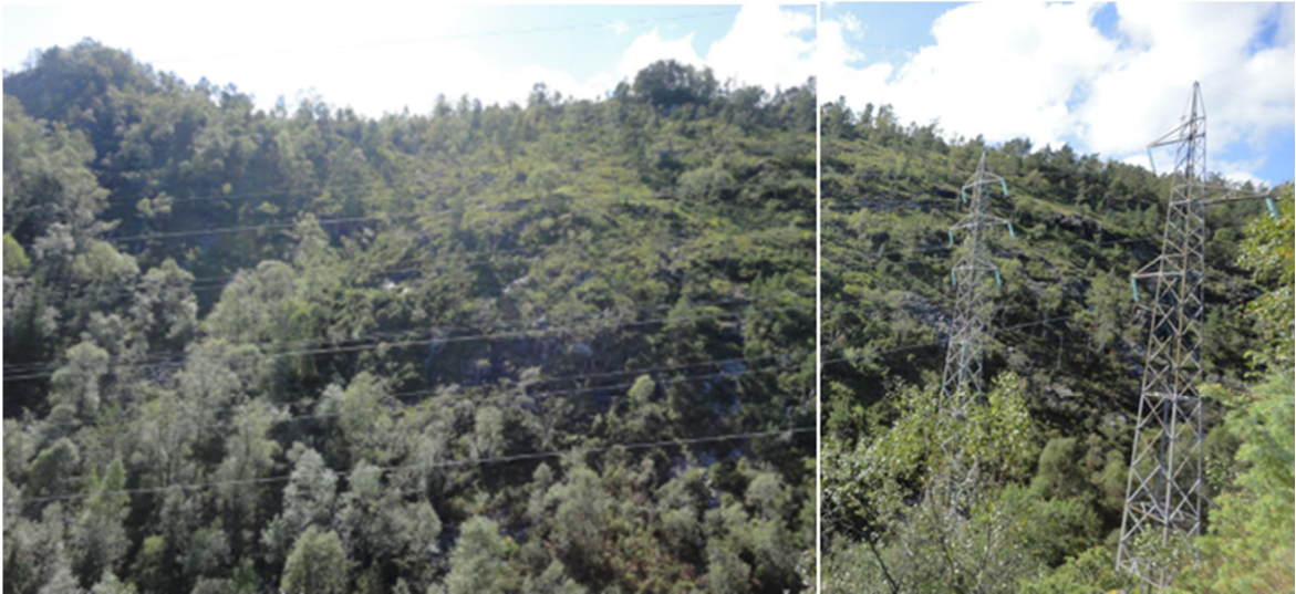
Bilde 4: Skrent ved kraftstasjonen under Husheia/Novedalen. Veien er planlagt mellom skrenten og kraftmastene.
