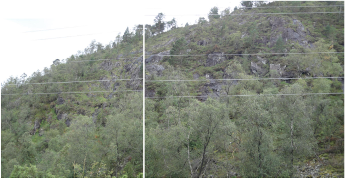
Bilde 3: Skrent ved kraftstasjonen under Merkeshaugen. Her er veien planlagt like under skrenten.
