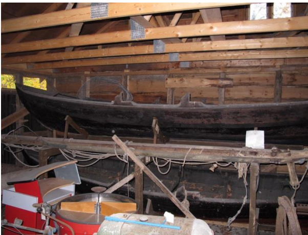
Ved Hordamuseet brukes «Hall 8» til oppbevaring av store gjenstander. Bygningen er av tre med jordgulv og åpninger der kun er blokkert med hønsenetting. Der er derfor stort sett uteklime året rundt. Her nedbrytes gjenstandene både av dyr, insekter, korrosjon og fysisk/mekanisk slitasje. Prioriteringsarbeid og flytting til nytt magasin pågår.
