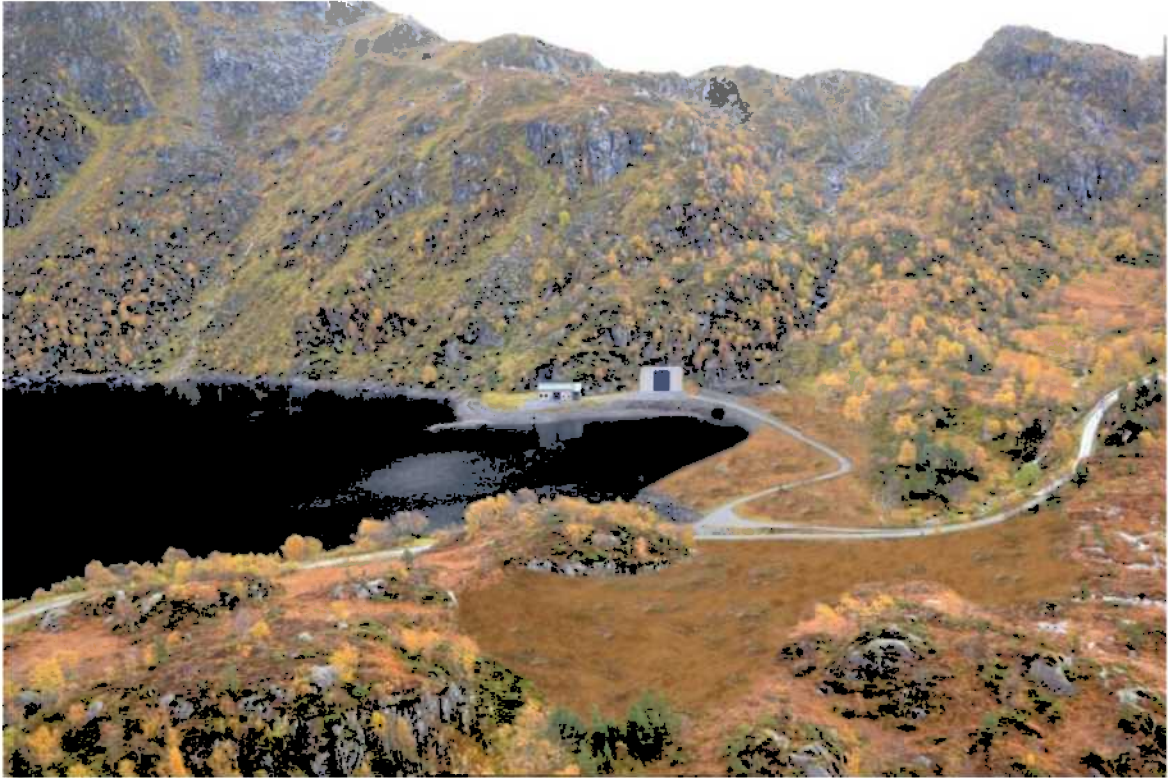
Figur 4.8. Visualisering av påhogg for tilkomsttunnel og massedeponi ved Staffivatn. Staffi kraftverk ligg til venstre for portalen.
