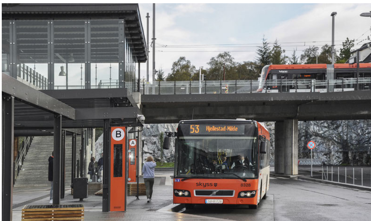
Byggetrinn 2 av Bybanen, Nesttun-Lagunen vart offisielt opna for trafikk 21. juni 2013. Foto: Ann Steindal
