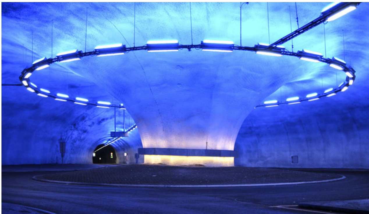
Rundkøyninga i Butunnelen ved Hardangerbrua. Dette riksveganlegget medverkar til regional utvikling i Hordaland. Foto: Geir Brekke, Statens vegvesen
