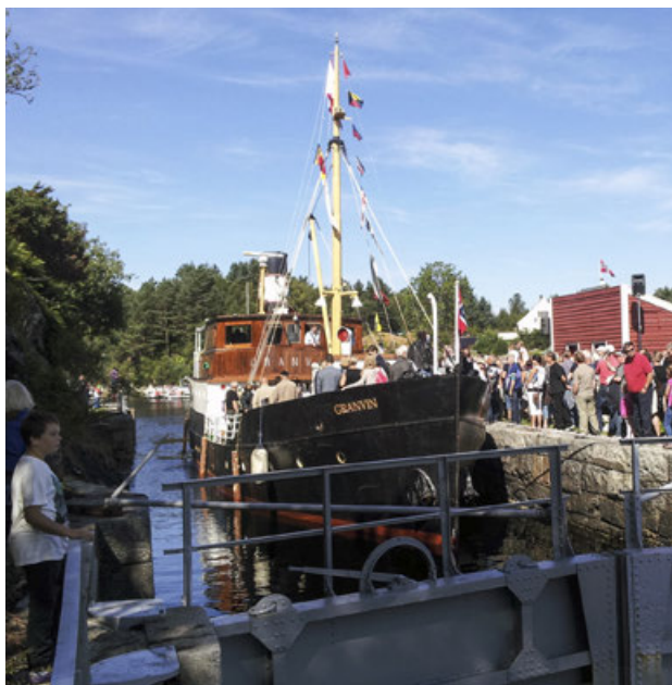
Istandsetting av portane ved Lindås sjøsluser, offisiell opning av anlegget i august. Foto: Stein Ottosen
