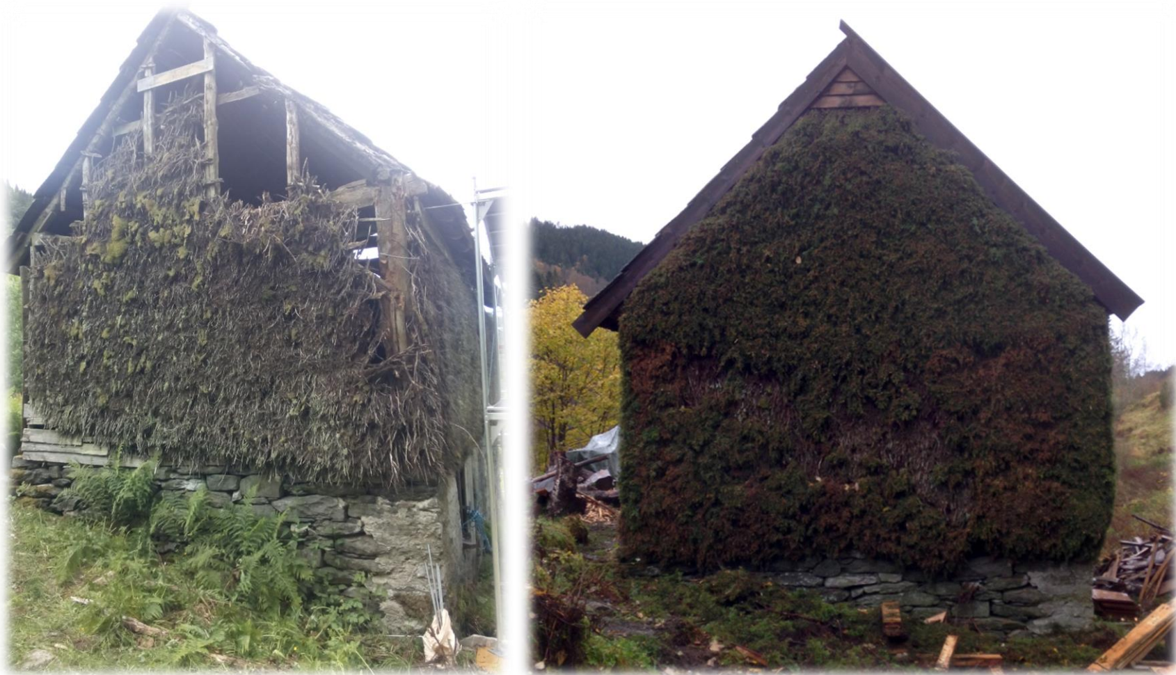
Figur 2: Sydside, før restaurering til venstre og etter restaurering til høyre.
