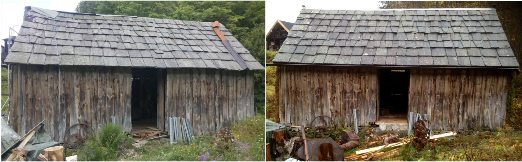
Figur 4: Brakeløe mot øst før restaurering til venstre og etter restaurering til høyre.
