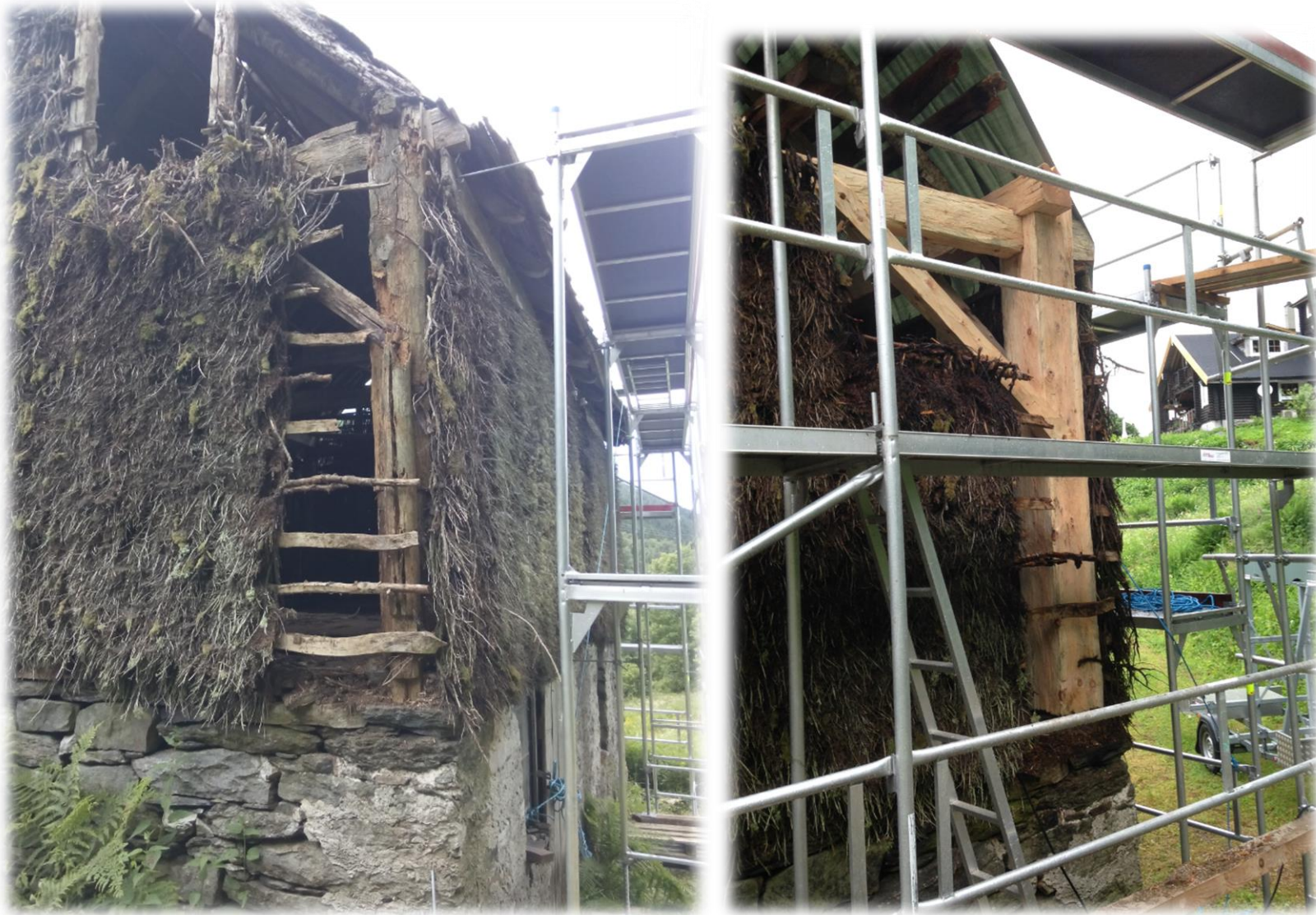
Figur 9: Grindkonstruksjon stav, bete og stavleire før og etter fra utsiden.
