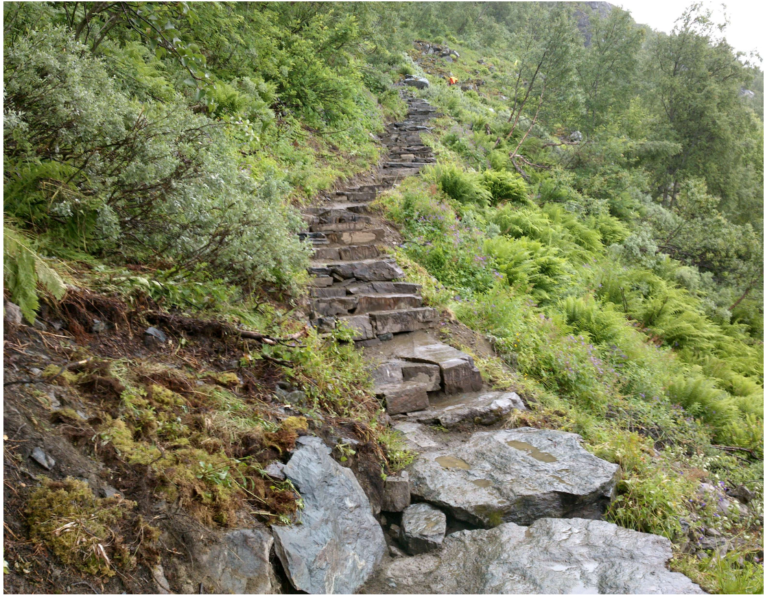
Opprusta trepper med stadeigen stein
