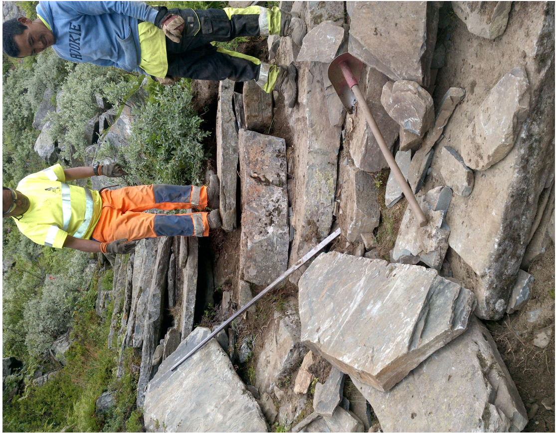
Rehabilitering av gamal trapp
