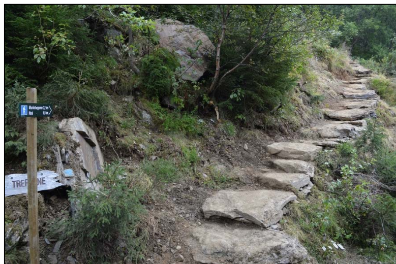
Eitt av punkta der skogsvegen kryssar stien. Her var det før berre ei bratt og glatt jordskråning. Nye trapper her gjer at dette partiet av stien no er mykje meir brukt. Foto: HFK
