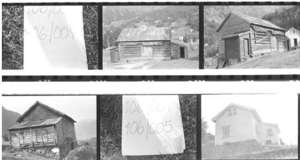
Fra SEFRAK-registreringen utført i 1982
