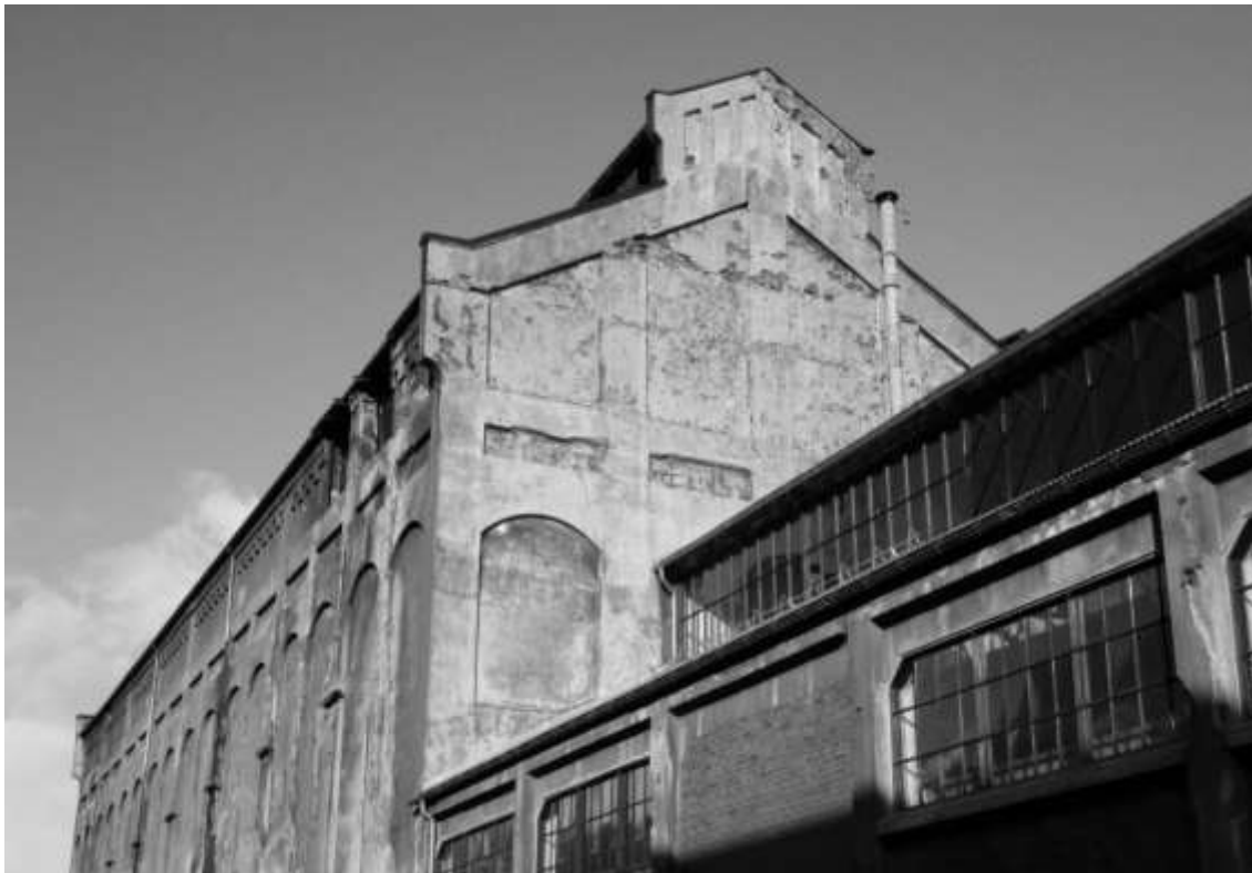
Cyanamiden fra 1907 er en av Norges aller første store bygninger i armert betong.
